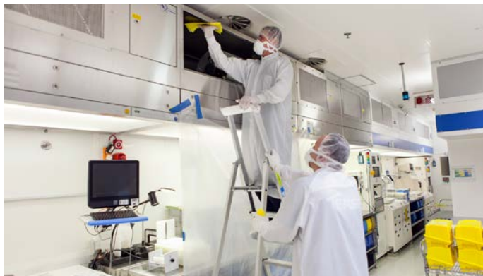
Das Equipment, das im Reinraum zum Einsatz kommt, ist entsprechend der Verordnung DIN EN ISO 14644-1 sowie den Vorgaben des Auftraggebers reinraumtauglich.
