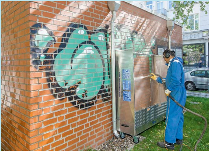
In diesem Fall wird mit einem Produkt auf Kalkbasis gearbeitet. Auch der Druck ist auf die Oberfläche abgestimmt: Mit maximal ein bis zwei Bar entfernt der Gebäudedienstleister die Graffiti an dem Mauerwerk.
