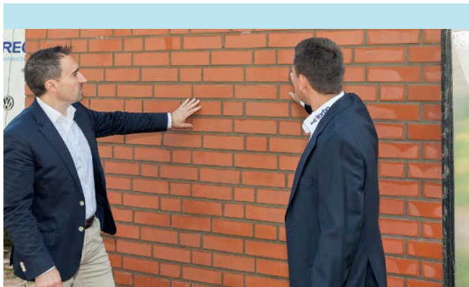
An Klinkerfassaden wie dieser werden mit dem Feuchtsandstrahl-Verfahren bemerkenswerte Ergebnisse erzielt. Im Anschluss an die Graffitientfernung ist eine Graffitiprohylaxe empfehlenswert. Bilder: Tereg
